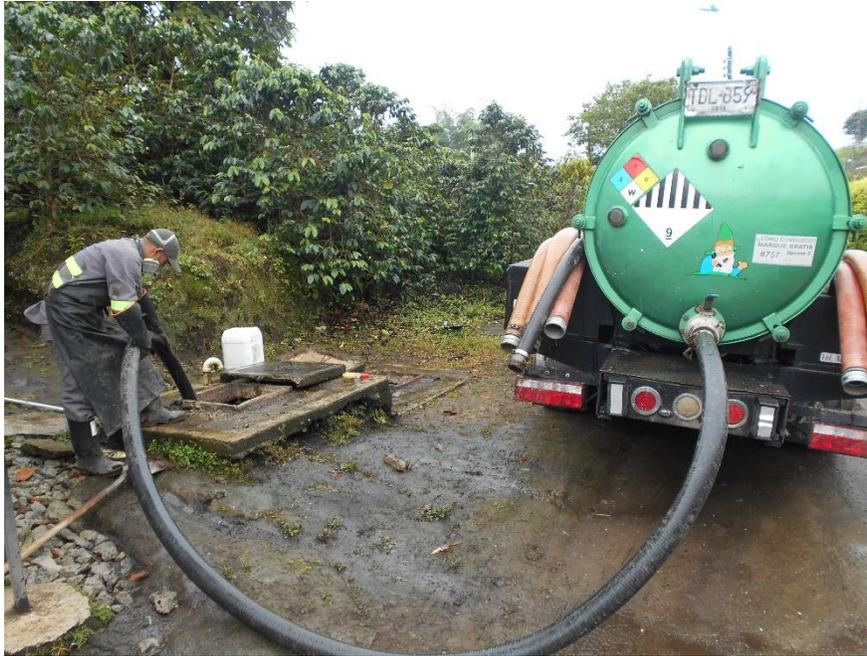
Fotografía 1 Procedimientos en el mantenimiento de Pozos
